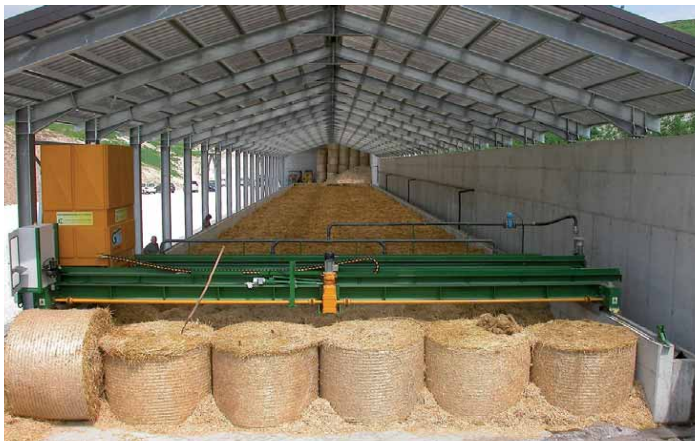
▼ Un'immagine del Biodigestore CLF Modil da una testata. La vasca è lunga 80 metri e larga 10. In primo piano il carroponete che scorre longitudinalmente sopra la vasca, trasversalmente si muove il castello che provvede, con il movimento delle coclee, alla movimentazione e all'arieggiamento della biomassa. La vasca è delimitata da due muretti laterali alti 130 cm. Quello a destra nell'immagine contiene la vasca entro la quale le pompe inviano il liquame proveniente dalle fosse di stoccaggio. Non passa inosservata la copertura, necessariamente rinforzata per essere a prova di nevicate invernali. Putrelle in acciaio e doppia capriata. L'altezza minima laterale è di 4,75 metri e quella massima centrale 6.
